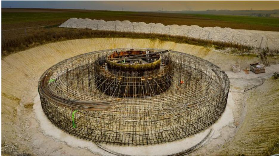
1 500 tonnes de béton sont nécessaires pour construire le socle d'une éolienne !
